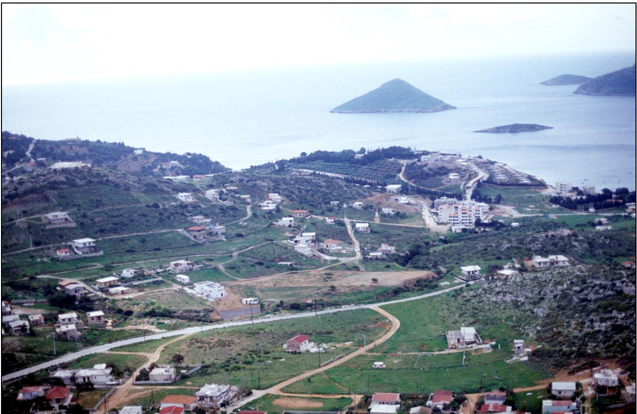
Εικόνα 3: Οργανωμένη δόμηση και ασχεδίαστη ανάπτυξη στην περιοχή του Πόρτο Ράφτη Πάνω: Φωτογραφική σύνθεση / Κάτω: Πραγματική κατάσταση
